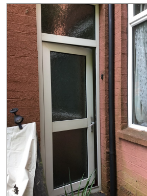
Photo - 31 UPVC side door
