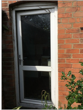
Photo - 32 Back door
